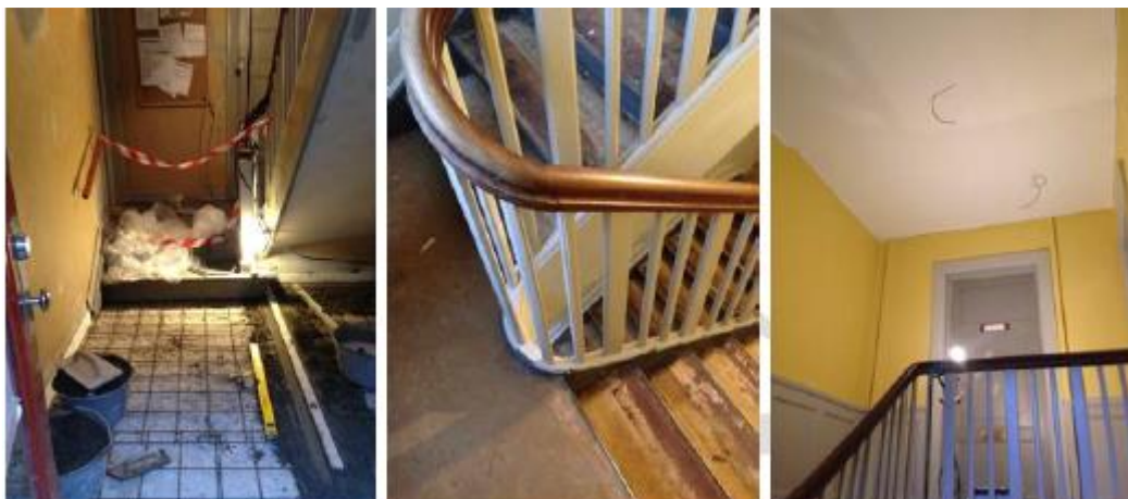
Fotos fra istandsættelsen af de første trapper på Ved Linden 13 og 11.
